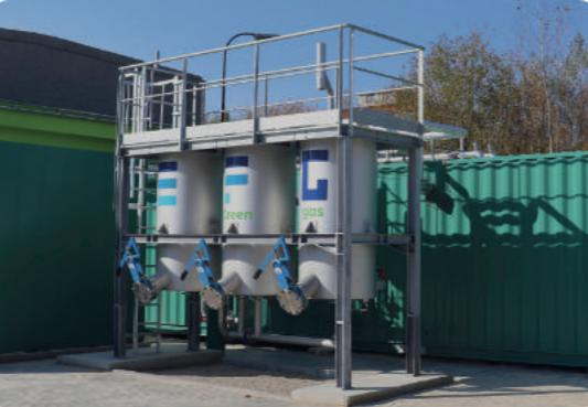
Stanice pracuje v kontinuálním mezofilním režimu (okolo 40 °C) a zpracuje až 30 000 tun odpadu za rok, což odpovídá produkci asi 5 000 000 Nm<sup>3</sup> bioplynu a 23 000 tun organicko-minerálního hnojiva. Ročně vyrobí energii odpovídající spotřebě 2 000 domácností.
