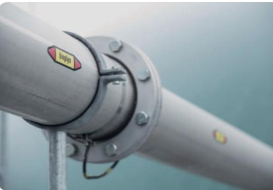
Upgrading bioplynu na biometan se provádí technologií membránové separace plynů. Separováním CH<sub>4</sub>, CO<sub>2</sub> a dalších molekul získáváme plyn s obsahem nejméně 99 % metanu. Princip membránové separace je založen na rozdílné průchodnosti molekul plynů membránou.
